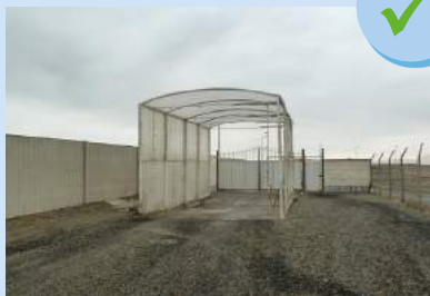
Túnel de desinfecção para veículos
