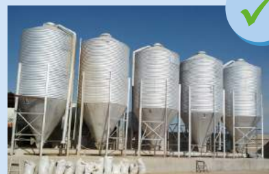
Silos em boas condições
