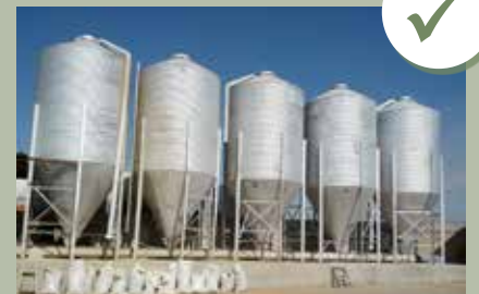
Silos em boas condições
