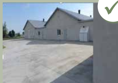
Zona adjacente cimentada
